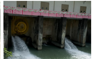
烏山頭ダム放水口
